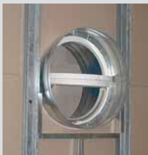
Isonne+ Ap in fase di installazione
